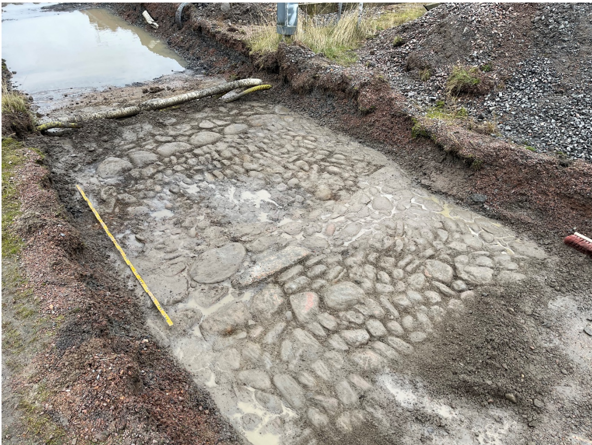
Figur 4. Framrensad stenläggning i mitten av undersökningsområdet. Foto mot norr.
