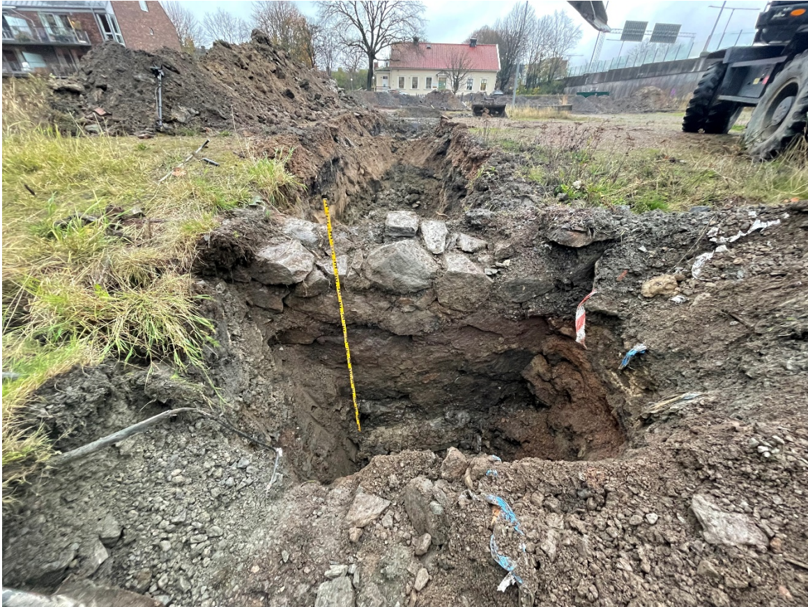
Figur 3. Grundmur tillhörande den sydvästra huslängan av Kungsladugård. Foto mot nordöst.
